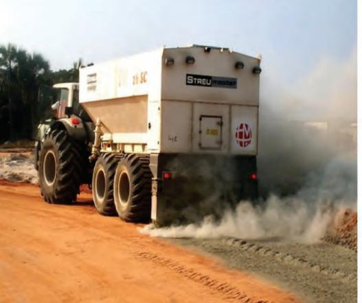
Consolid 444 nano zemin stabilizatörü su tankına ilave edilerek seyreltilir ve su tankı yardımı ile hazırlanmış zemin üzerine serpilir.
