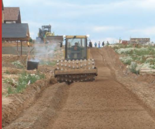
■ Consolid nano zemin güçlendirme teknolojisi ile homojen karıştırılmış zemin keçi ayağı silindir ile sıkıştırılır.
